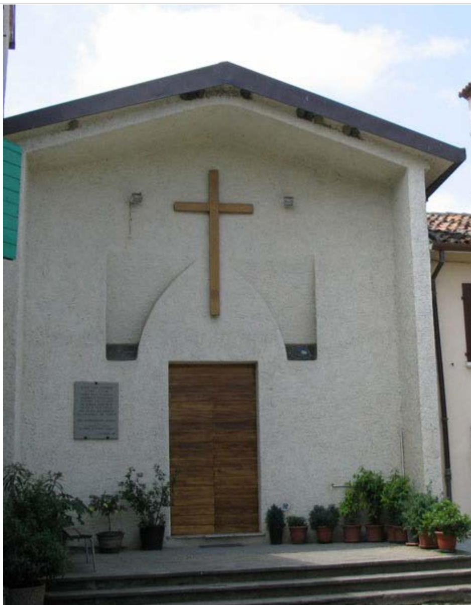
La chiesa restaurata
