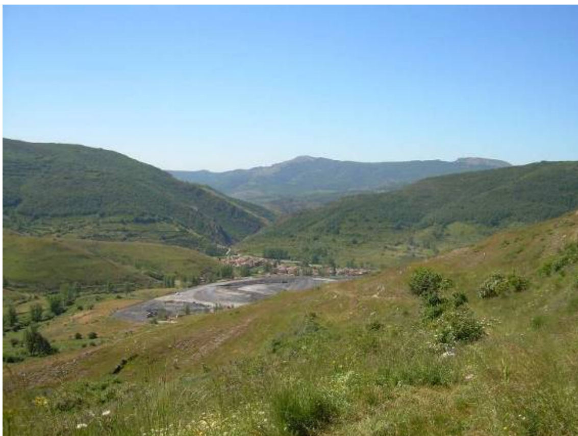
Il paese di Buiza visto dall'alto; al centro la cava per la costruzione della nuova strada.
